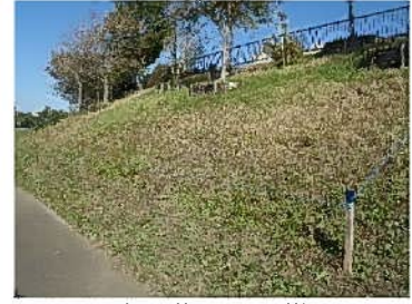
法面草刈りの様子
