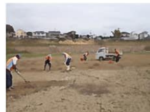
芝生に堆積した土砂の除去作業
